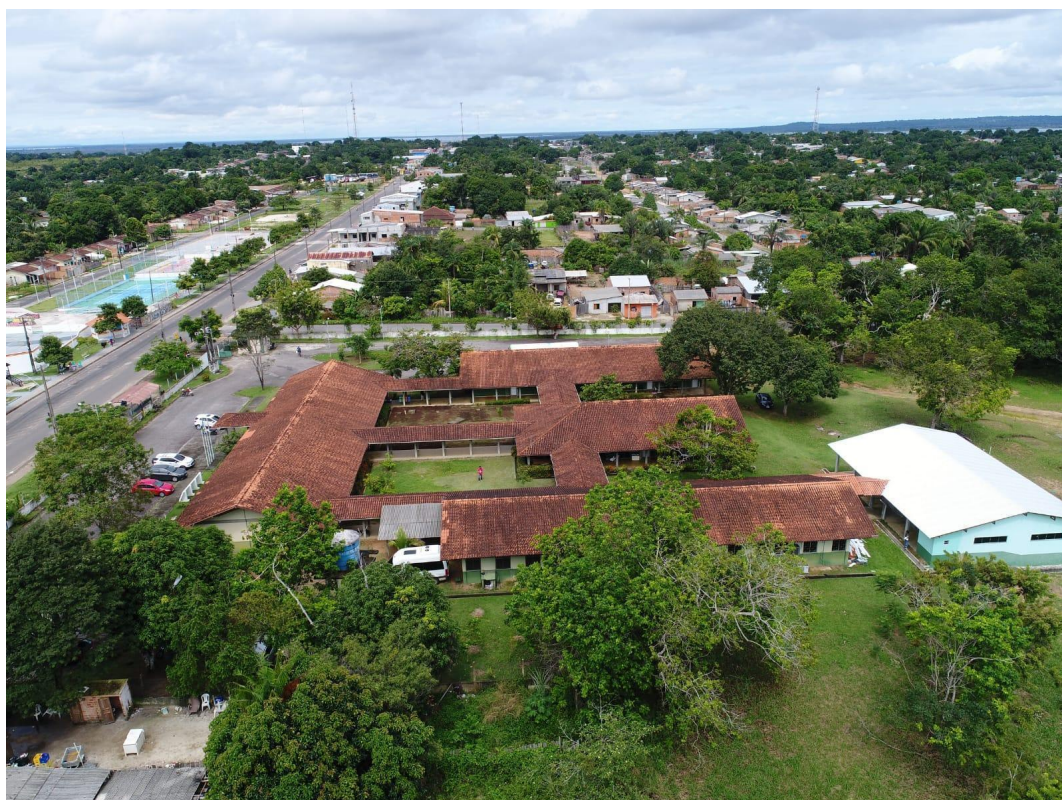
Figura 2. Imagem aérea do Campus mostrando o anexo (verde claro e trilhado metálico) construído em 2020. Foto: Maico Pimentel.
